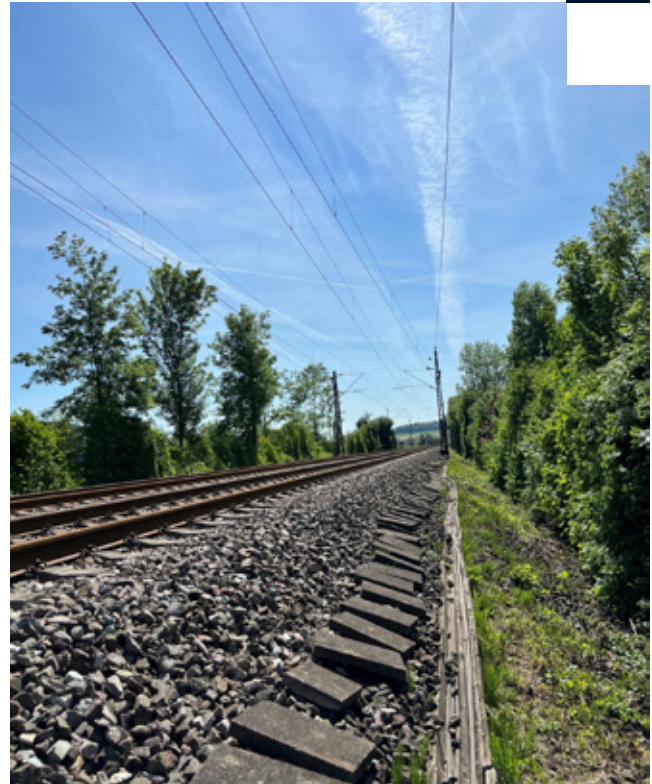
Abb. 15: Strecke mit offenem Kabeltrog während Bauarbeiten
