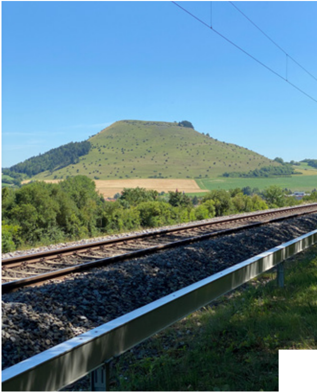
Abb. 16: Weitere Bauform des Kabeltrags
